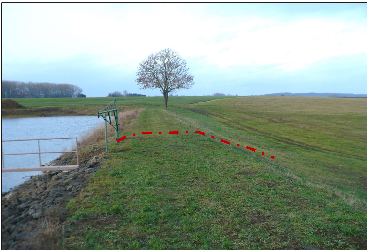
Obr. 6: Pohled na korunu hráze, naznačeno navýšení cca uprostřed staničení hráze
