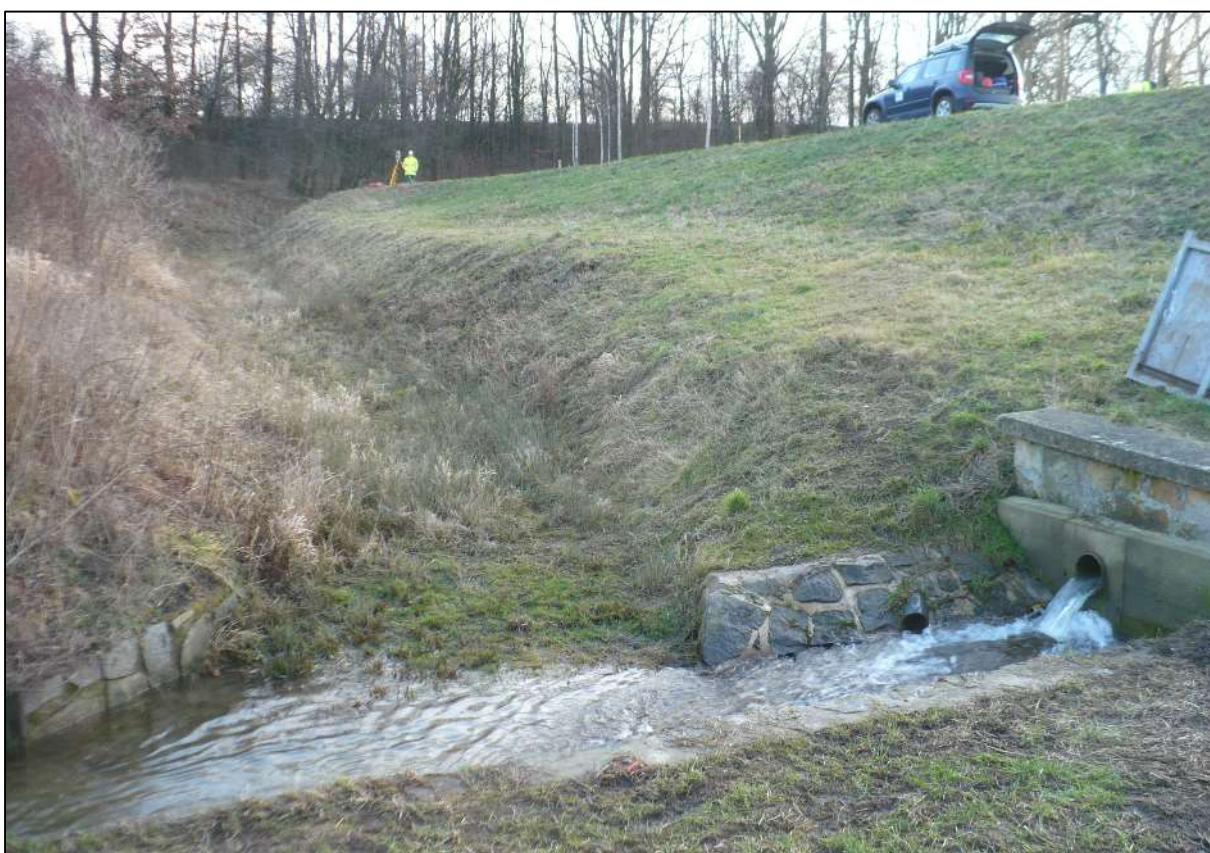
Obr. 3: Odpad od BP (koryto), spodní výpust, vyústění pat. drénu a opevnění navazující části Kozojedského potoka
