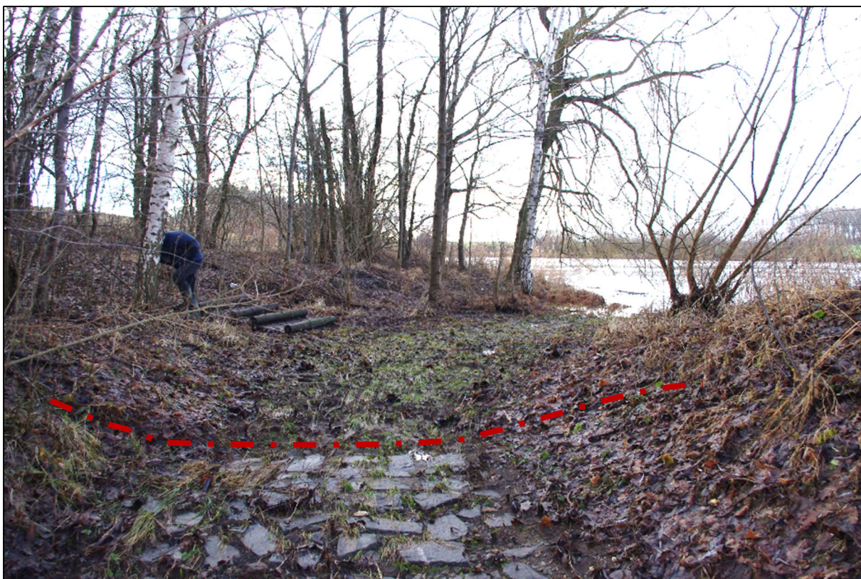
Obr. 2: Stávající BP – bet. práh vyznačen červeně, zemina v předpolí zvyšuje skutečnou niveletu BP
